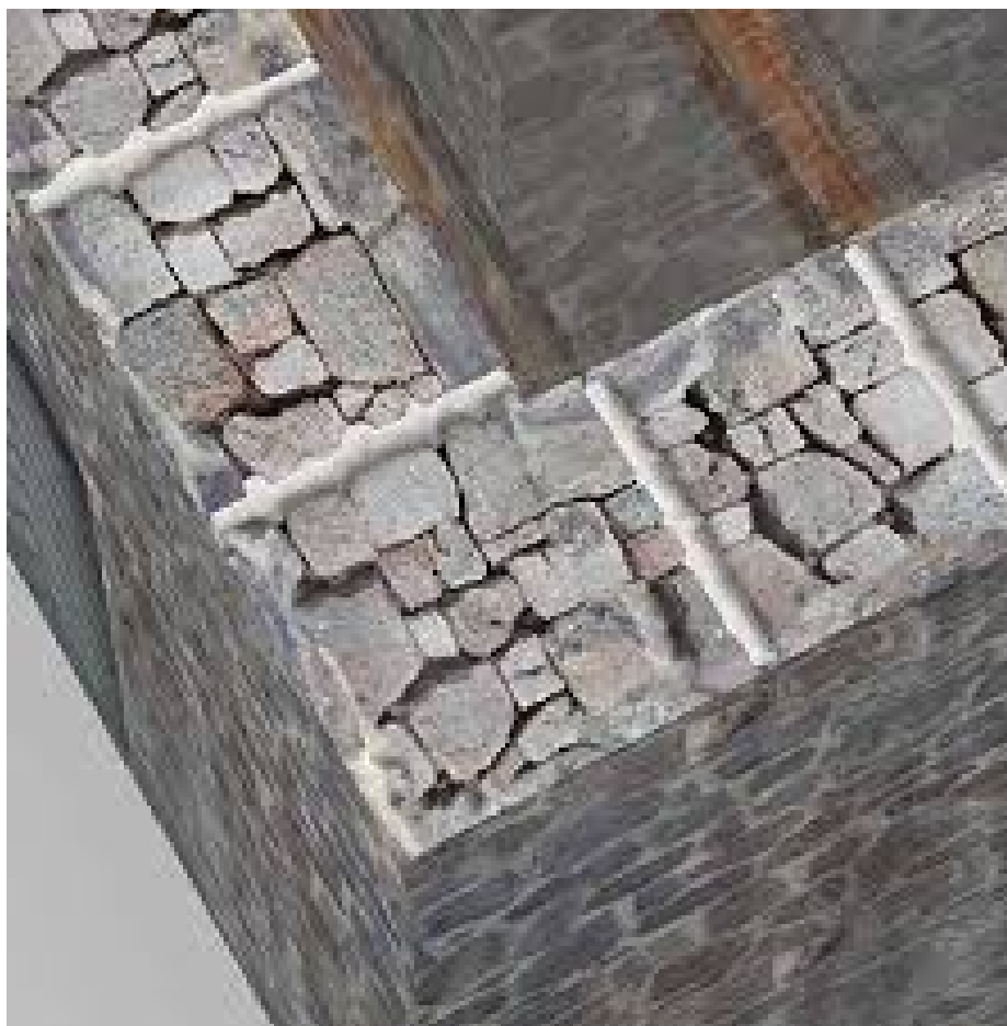
Vormauerschale mit Luftschicht
